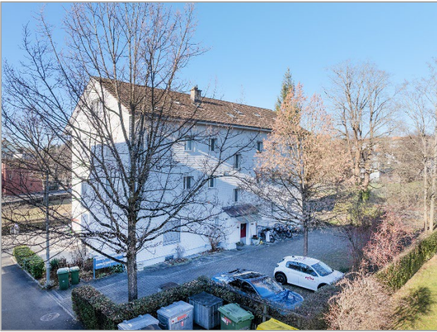
Ostansicht mit Parkplätzen
